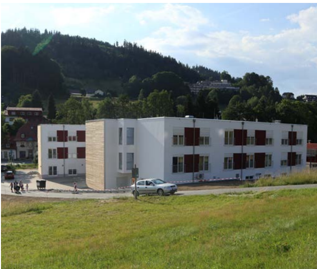
Das fertiggestellte Seniorenwohnheim im Juli 2018
