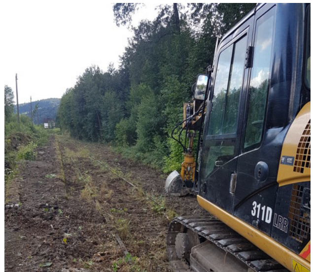
Bauarbeiten Radfernweg nach Weidenberg Quelle: Gemeinde Warmensteinach
