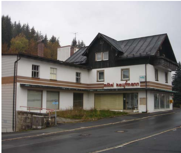
Abb. 109 Bestandssituation des ehemaligen Kaufhauses
