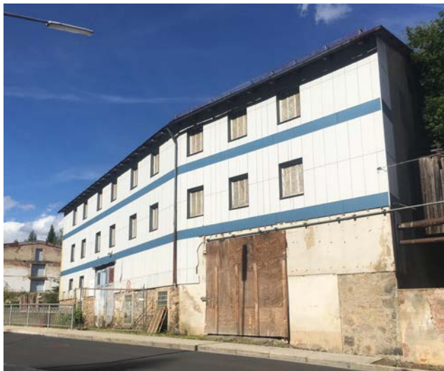
Abb. 121 Fassade des ehemaligen Schamottewerks
