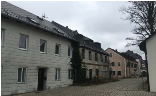
Abb. 74 Leerstehende Gebäude am Kirchenring
