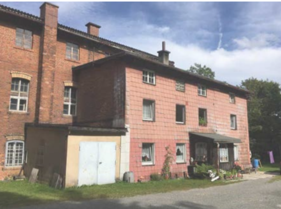
Abb. 42 Fassade des ehemaligen Fabrikgebäudes
