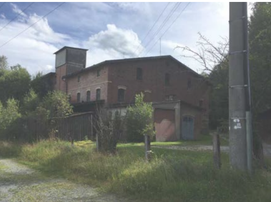
Abb. 41 Blick auf das ehemalige Fabrikgebäude
